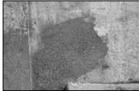
Facciata nord-ovest, parte bassa sinistra vicino al portale
