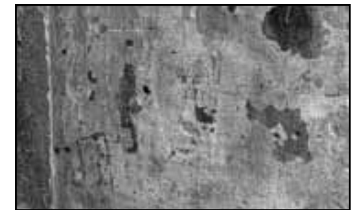
Facciata nord-ovest, particolare tinteggiatura facciata
