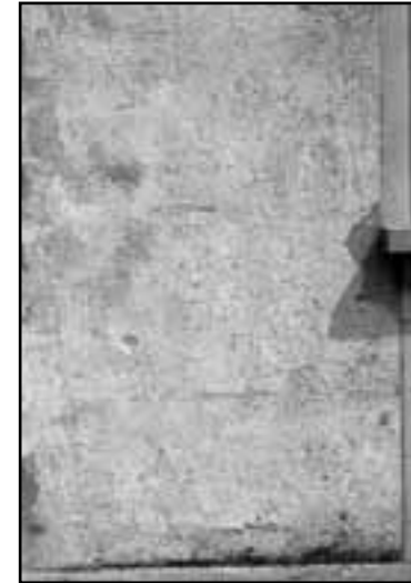
Particolare facciata nord-ovest, lato destro
