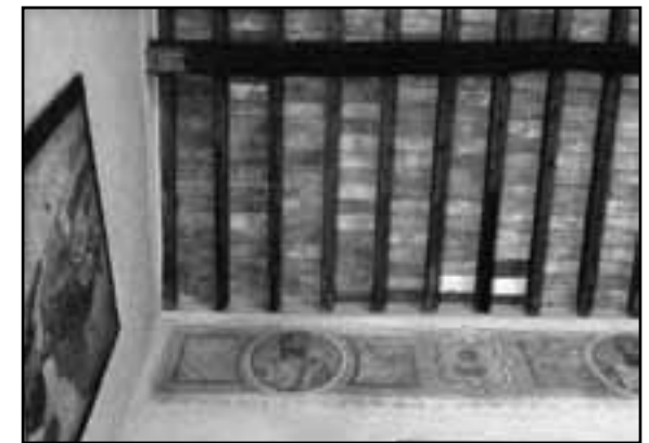
Copertura aula principale
