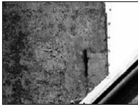
Campanile, particolare intonaco
