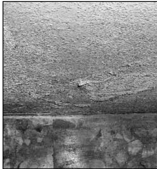
Aula rettangolare, interno, particolare muratura lato nord-est
