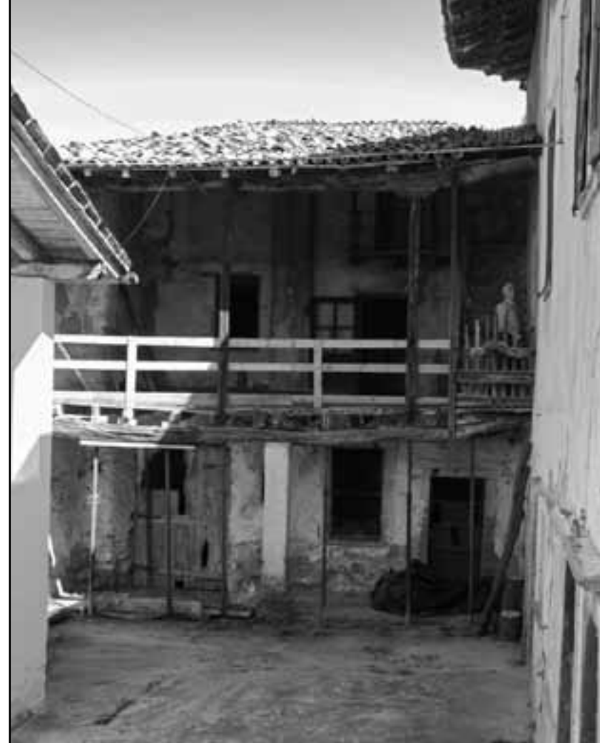
Edificio 7: la corte rustica della casa Cristini degli Afre
