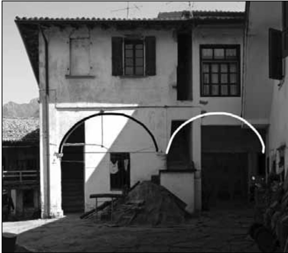
Edificio 7: il prospetto meridionale sulla corte superiore; si notano le tracce - poste in evidenza - degli archi del portico originario
