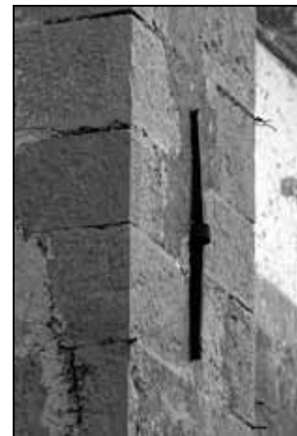
Facciata nord-est, contrafforte
