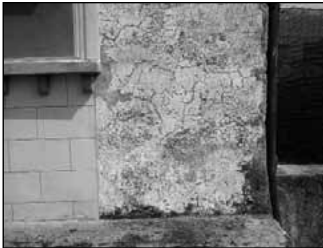
Particolare facciata nord-ovest, parte destra
