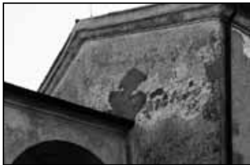
Facciata nord-ovest, parte alta sopra copertura pronao
