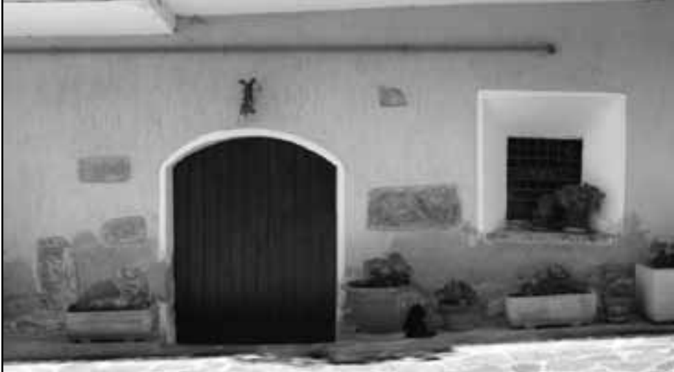
Edificio 3: tracce di murature antiche sul prospetto meridionale
