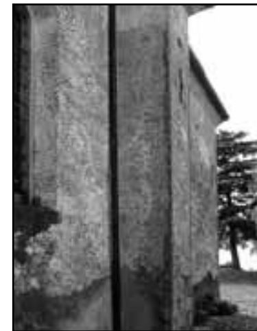
Facciata nord-est, contrafforte
