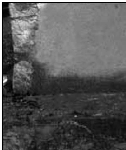
Particolare facciata nord-ovest, spigolo nord
