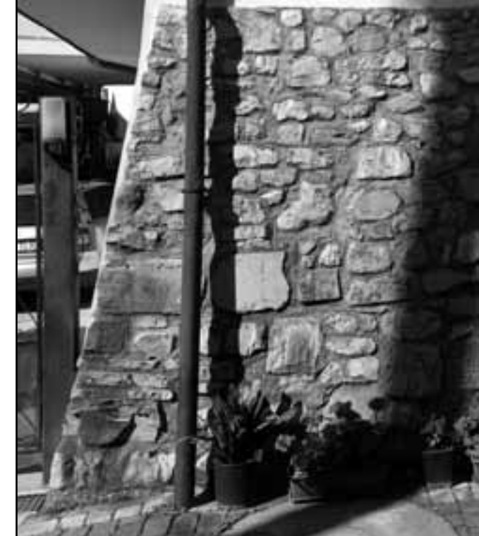
Edificio 1: paramento murario a scarpa
