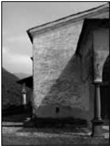
Facciata nord-ovest, parte sinistra
