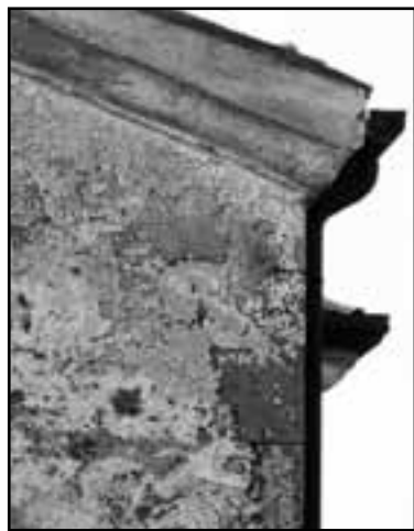
Particolare facciata nord-ovest, parte alta destra
