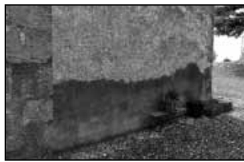
Facciata nord-est, parte bassa
