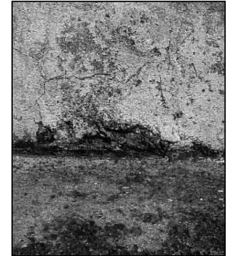
Particolare facciata nord-ovest, lato destro
