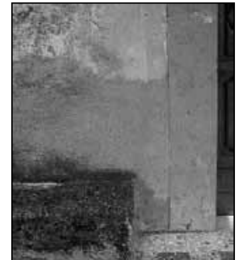
Facciata nord-ovest, particolare zoccolo lato sinistro
