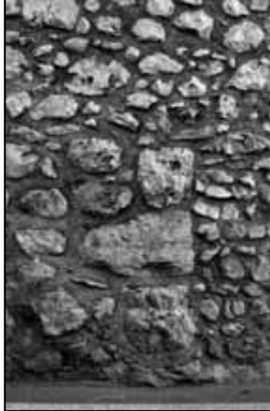
Edificio 1: particolare della testata angolare su via San Pietro
