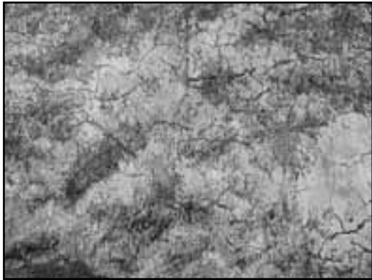
Particolare intonaco facciata nord-ovest, parte sinistra
