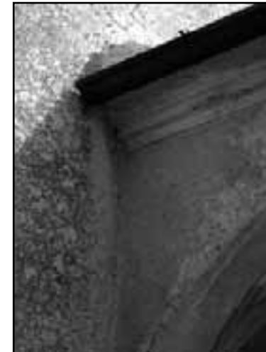
Particolare pronao, facciata nord-ovest
