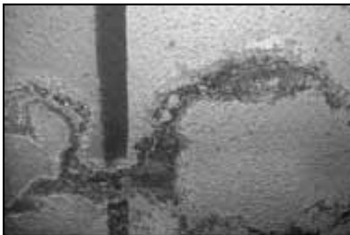
Aula rettangolare, interno, particolare muratura lato nord-est
