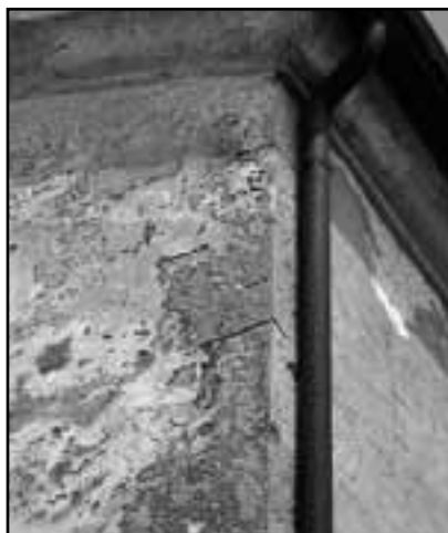
Particolare facciata nord-ovest, spigolo ovest
