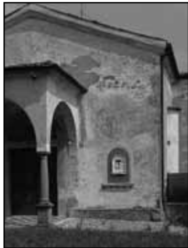
Facciata nord-ovest, parte destra
