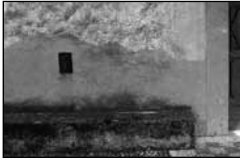
Facciata nord-ovest, parte bassa sinistra
