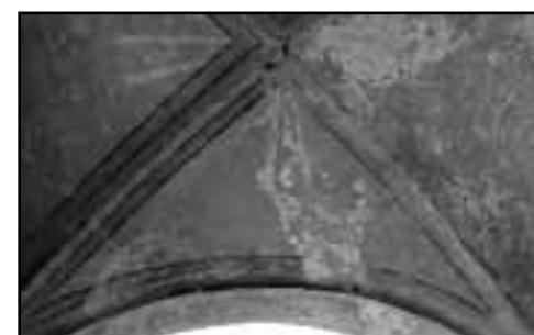
Pronao, copertura con volta a crociera, vela sud-ovest
