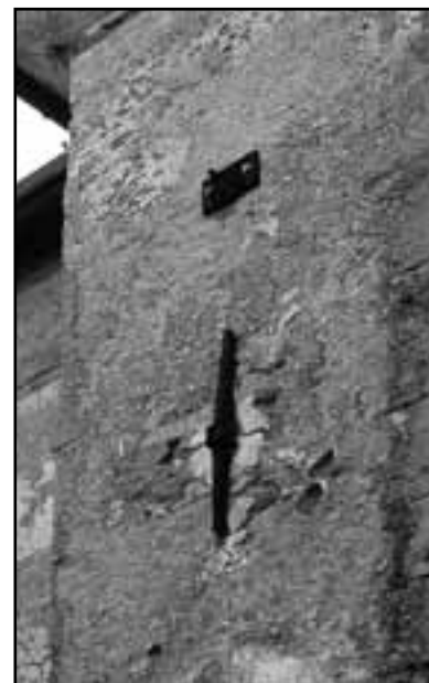
Facciata nord-est, contrafforte
