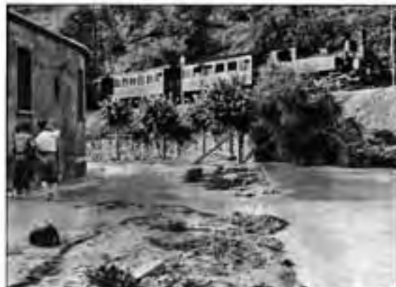
Marone, Lago d'Iseo. L'oragano ha provocato ingentissimi danni alla rete ferroviaria e stradale. Nel tratto Salsomarina-Pianega cinque sono i ponti crollati. La ferrovia è interrotta in diciannove punti diversi. Nella foto il treno per loco fermato miracolosamente una dozzina di metri prima di un cedimento del terrapieno. In prima piano gli alberi abbattuti.
