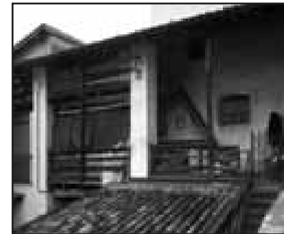
Veduta di via Mazzini con, a destra, gli ingressi ai diversi livelli delle corti
