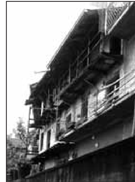
Contrada di via Castello, il prospetto meridionale del complesso edilizio 3a) con le strutture lignee ancora parzialmente conservate
