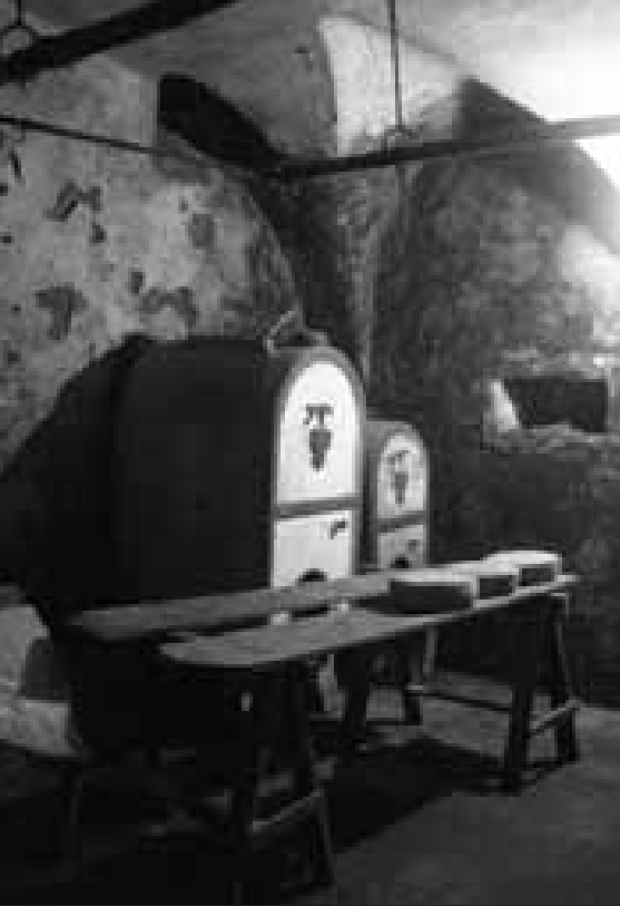
Edificio 2c), locale di cantina per la conservazione del vino e del formaggio
