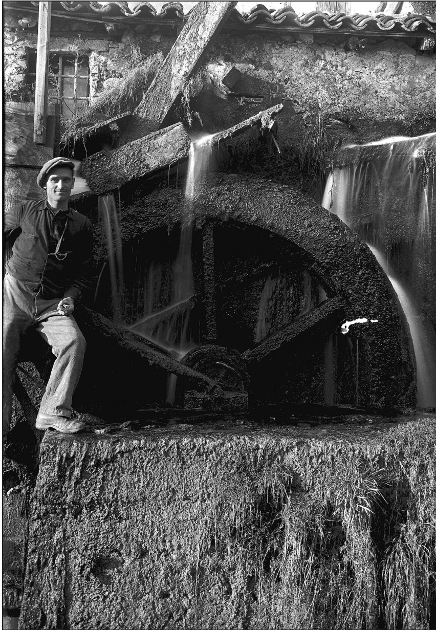
011 - L'immagine è di LAP (primi anni del '900). In essa è raffigurata la classica ruota da mulino detta "ruota di sopra", perché l'acqua che la muoveva colpiva le pale dall'alto; nelle "ruote di sotto" l'acqua le muoveva colpendole dal basso. La ruota da mulino mossa dall'acqua della Festola è all'origine della nascita di Marone: contrariamente a quanti molti pensano, essa era conosciuta in epoca romana, ed il suo uso venne "riscoperto" attorno all'anno 1000.
