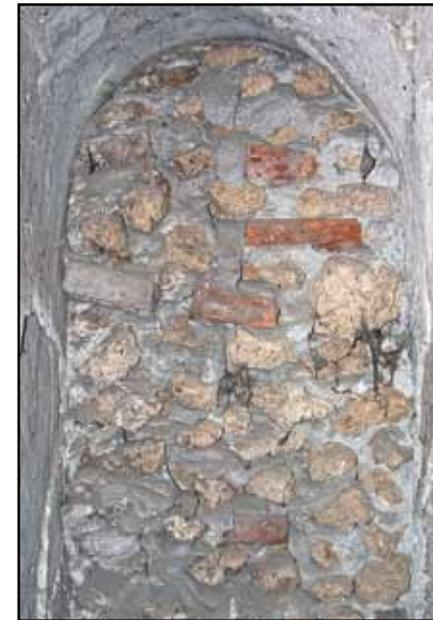
orizzontali. Confrontando gli elementi impiegati per il paramento esterno con quelli del paramento interno, appare evidente come i primi siano connotati da un livello di finitura superiore, nonostante che per entrambi si possa parlare di apparecchiatura regolare; questa non implica solo una migliore resa dal punto di vista estetico ma, anche, una maggiore adesione fra le singole parti e, conseguentemente, influisce positivamente sul comportamento monolitico dell'edificio.
