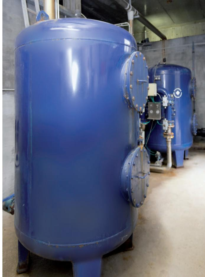
Il serbatoio dell'acquedotto **Filtri Sèstola** è situato in via Zone, località Gariolo, 100 m più a valle della strada Provinciale Marone- Zone. Parzialmente interrato ha una capacità di circa 300 m<sup>3</sup>. È alimentato dalla sorgente della *Sèstola* sita a 500 m di distanza in località *Sèstola* del Monte di Marone a pochi metri dal ponte che si attraversa andando verso l'abitato del Monte di Marone.
