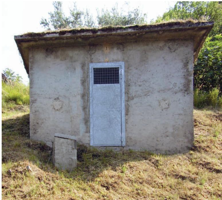
Il serbatoio dell'acquedotto di **Ponzano** è situato in via Montenero, distante circa 50 m dalla curva a gomito della strada Provinciale a Ponzano. Parzialmente interrato è formato da 1 serbatoio di capacità di circa 30 m<sup>3</sup>. È alimentato dal serbatoio **Filtri Sèstola**.
